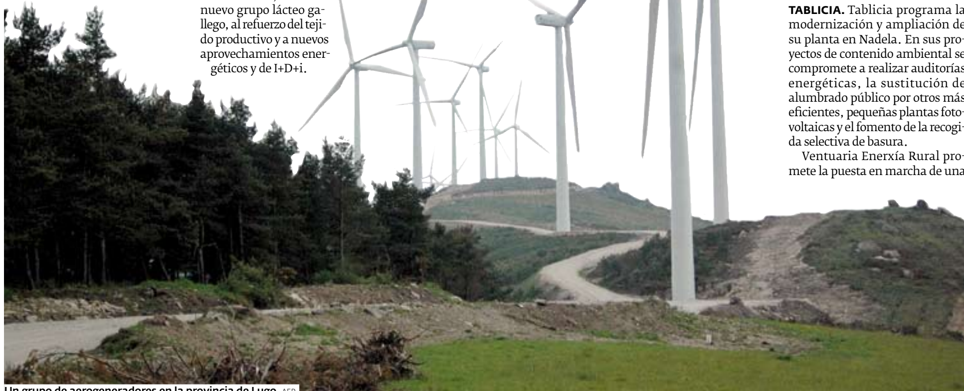
Un grupo de aerogeneradores en la provincia de Lugo. AEP
